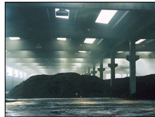
Impianto di compostaggio
